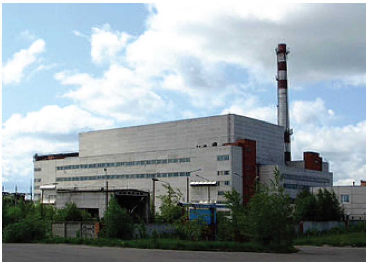
Рис. 1 АСТ-500 в г.Горьком ( на этапе строительства)
