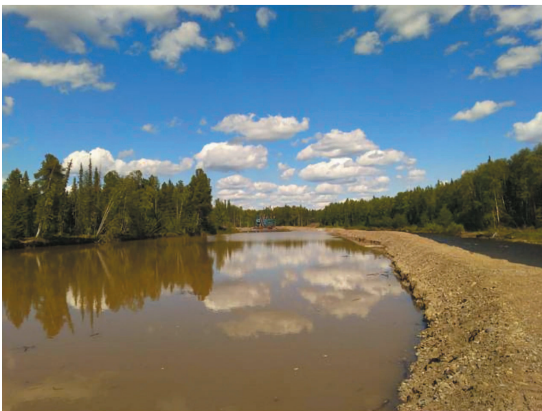
Рис. 2. Отстойник дражной добычи золота в устье реки Луцоуля (бассейн Северной Сосьвы) [20] Fig. 2. Sedimentation pond for gold dredging at the mouth of the Lutsoulya River (Northern Sosva basin) [20]
