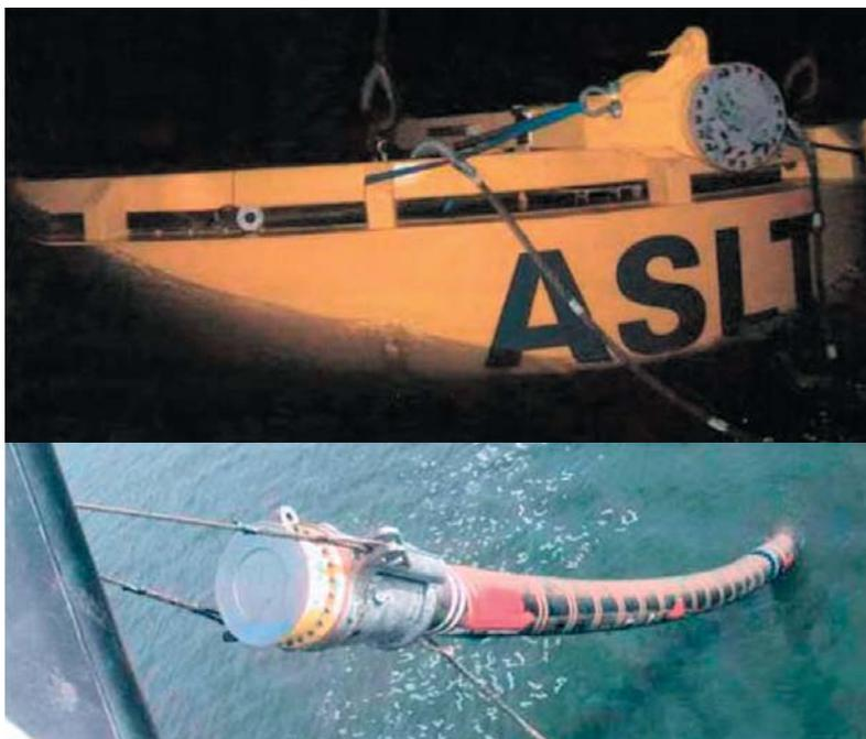
Рис. 1. Установка подводного отгрузочного нефтяного терминала в районе Варандея
